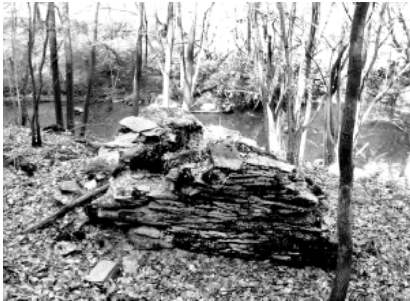
Fundament der Lumpenmühle
