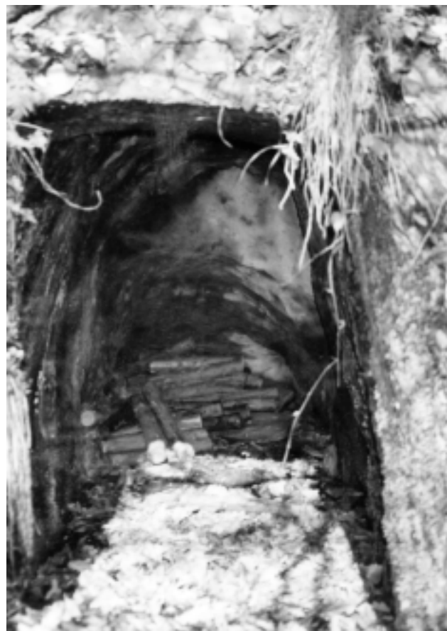
Der Eingang zum Schieferstollen „Mina“ bei der Lumpen-Mühle
