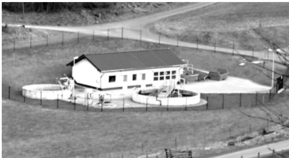
Kläranlage Dornholzhausen / Oberwies
