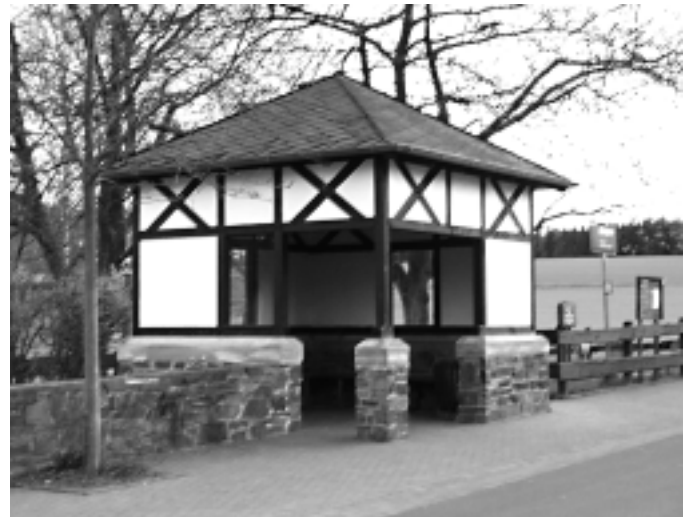
1988 neugestalteter Dorfplatz mit Wartehäuschen
